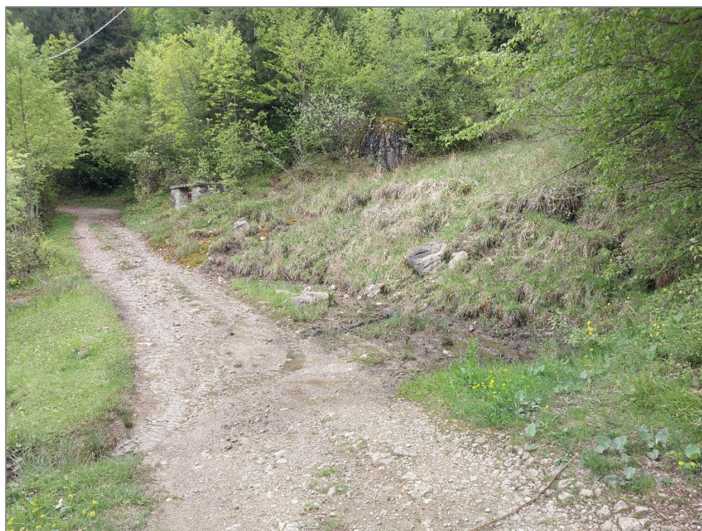
Figura 42 – Tratto 4B – Realizzazione pavimentazione in selciato e realizzazione fontana
