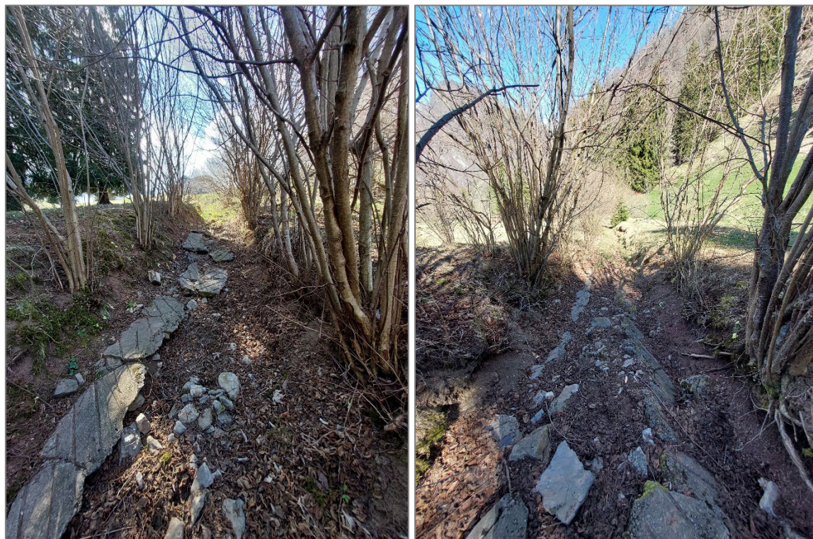
Figura 6 – Tratto 1 D - 1E – Demolizione pavimentazione esistente e realizzazione nuova pavimentazione in cls, con riprofilatura scarpate
