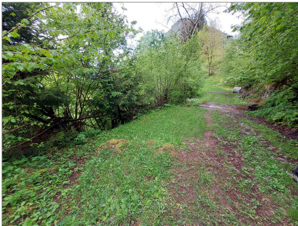
Figura 19 – Tratto 1L – 1H – Riprofilatura e livellamento piano area di sosta, realizziamone staccionata e posa tavolo da pic-nic
