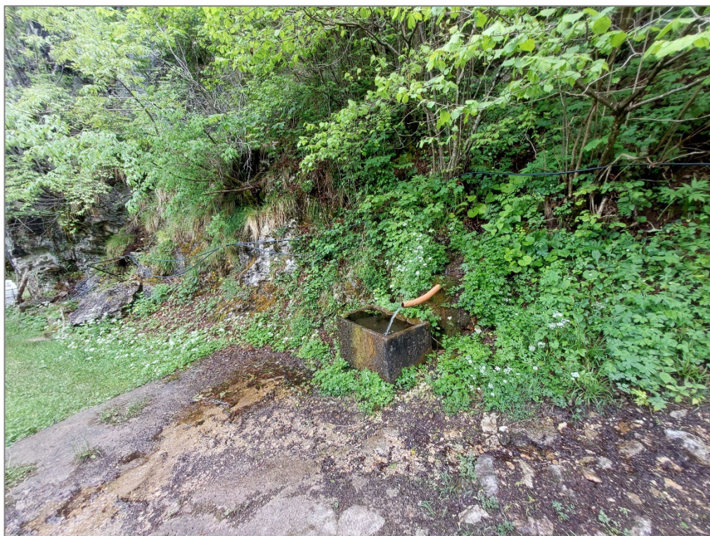
Figura 21 – Tratto 1L – 1H – Sistemazione fontana tipo 1
