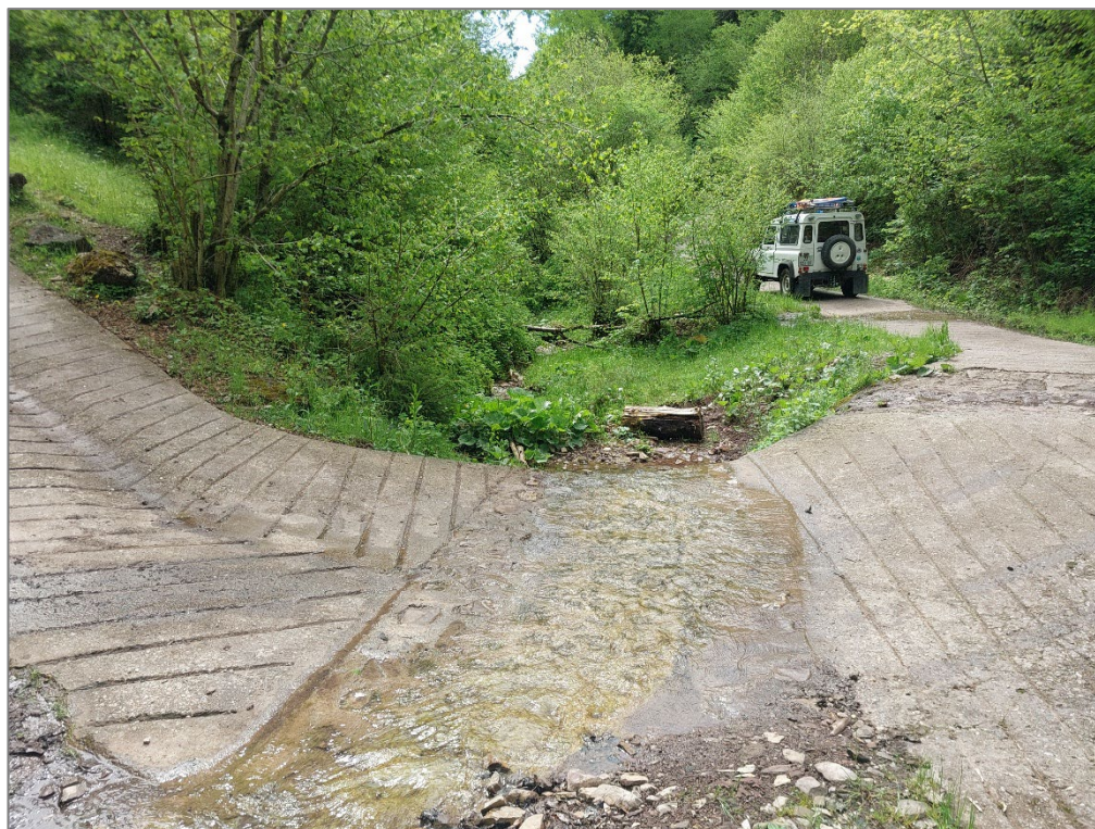
Figura 35 – Tratto 3A – 3B – Realizzazione vasca
