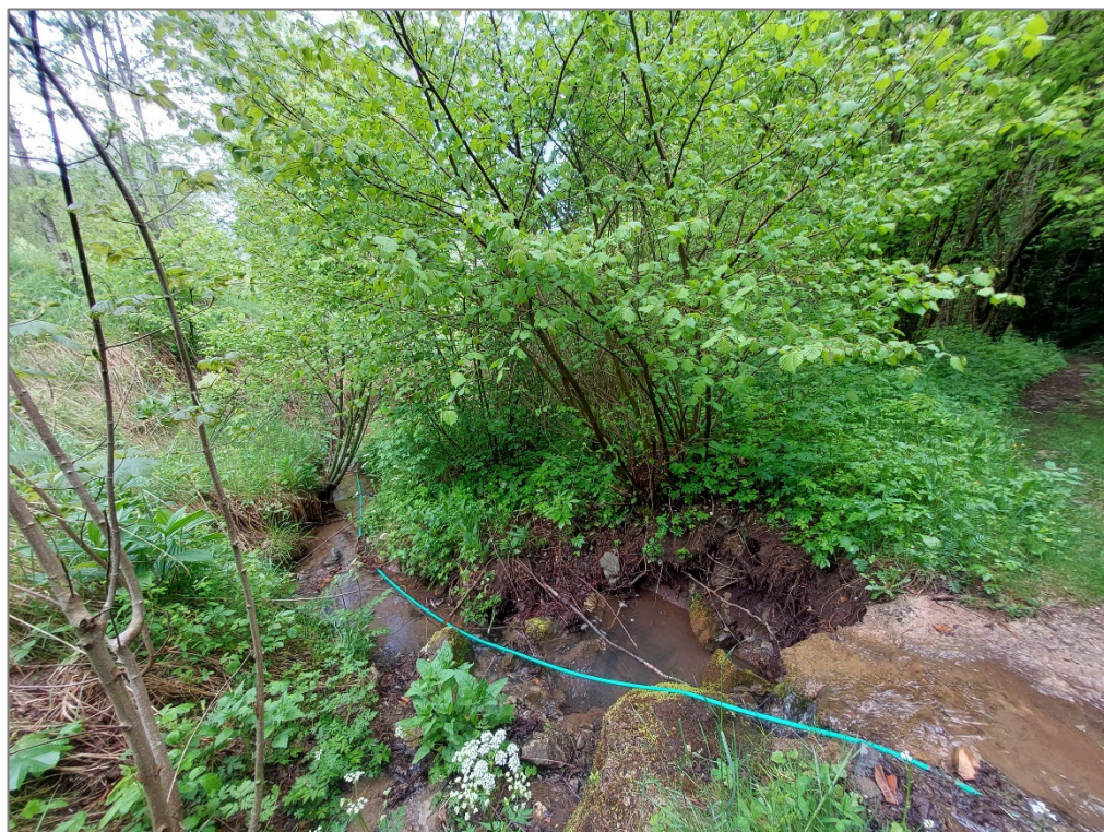
Figura 13 – Tratto E-F – Realizzazione vasca
