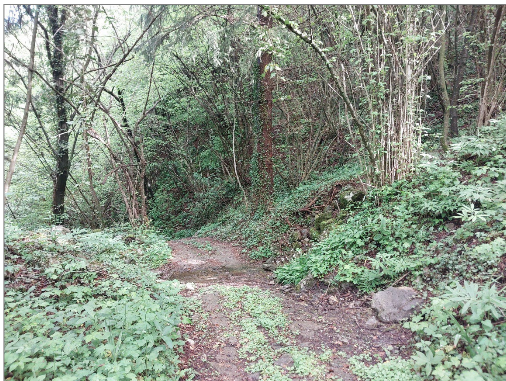
Figura 14 – Tratto 1G – 1L – Demolizione pavimentazione esistente e realizzazione nuova pavimentazione in cls
