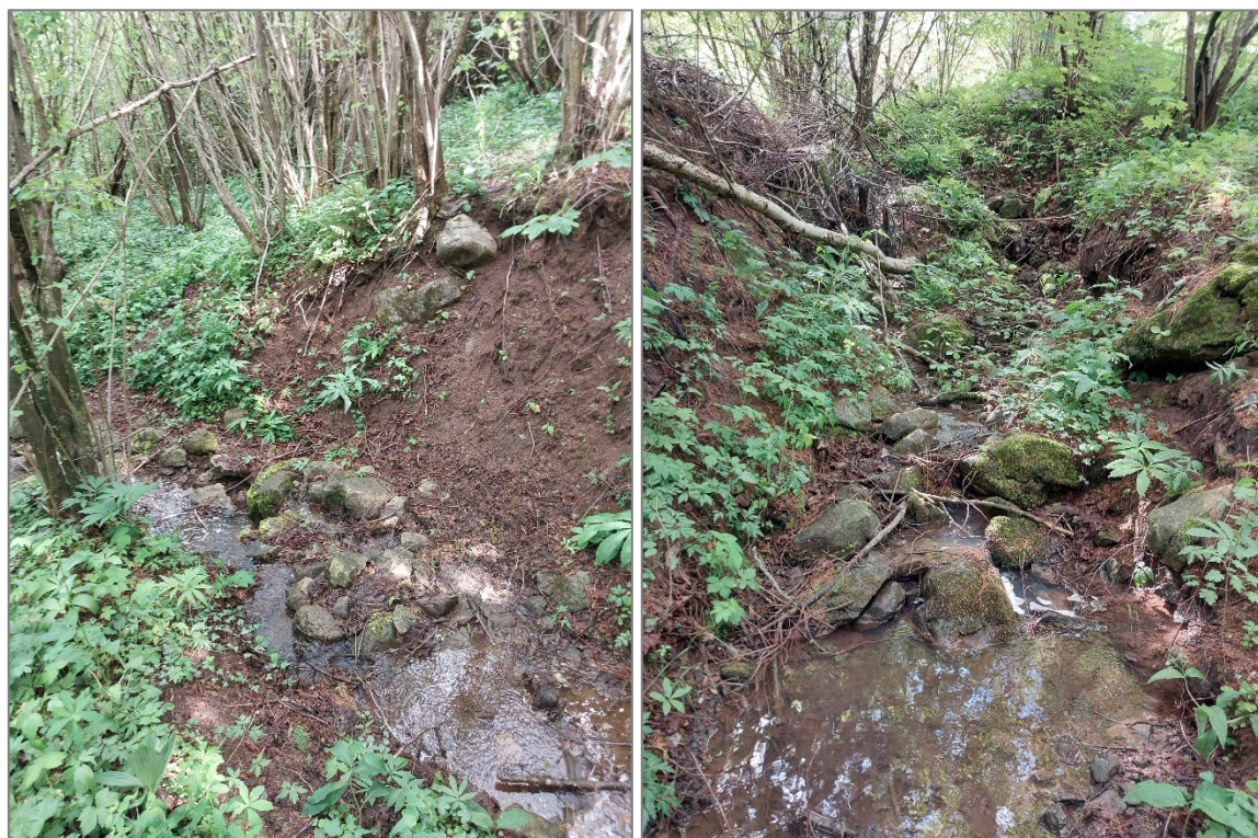
Figura 10 – Tratto 1E - 1F – Riprofilatura alveo monte del guado
