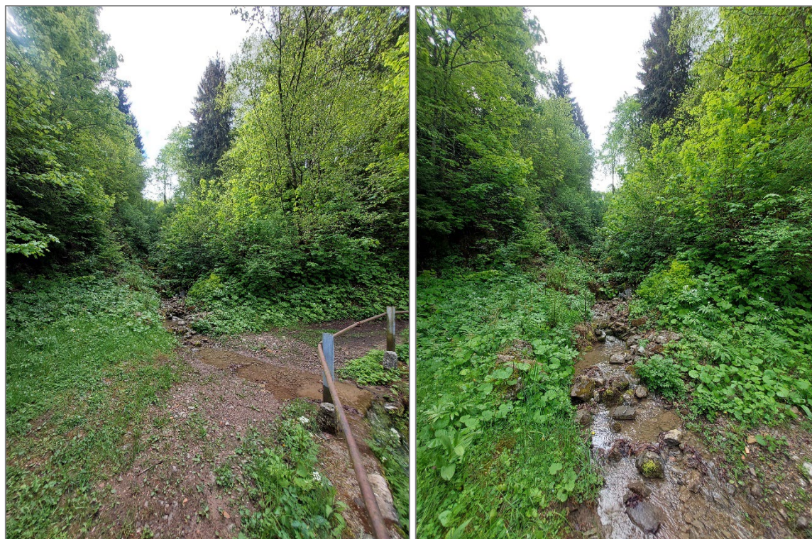
Figura 24 – Tratto 1H – 1I – Pulizia bosco, realizzazione vasca e rifacimento guado
