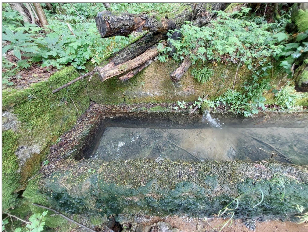
Figura 33 – Tratto 2E – Sistemazione fontana tipo 3
