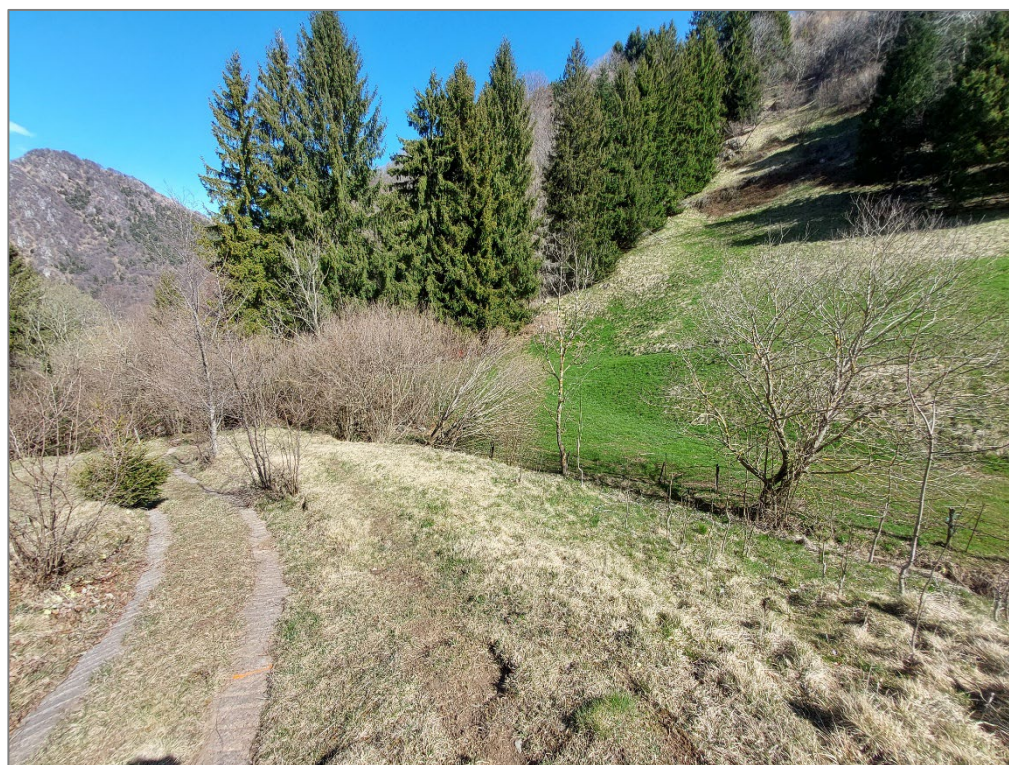
Figura 8 – Tratto 1E – 1F – Realizzazione canaletta scarico verso torrente
