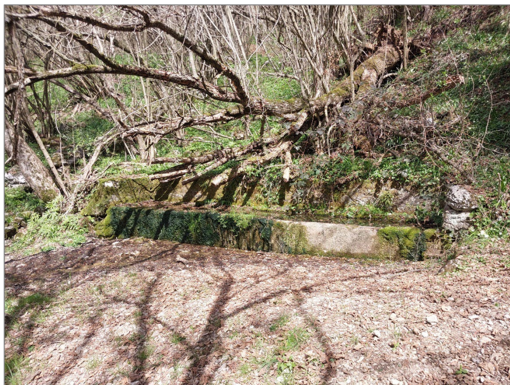
Figura 32 – Tratto 2E – Sistemazione fontana tipo 3
