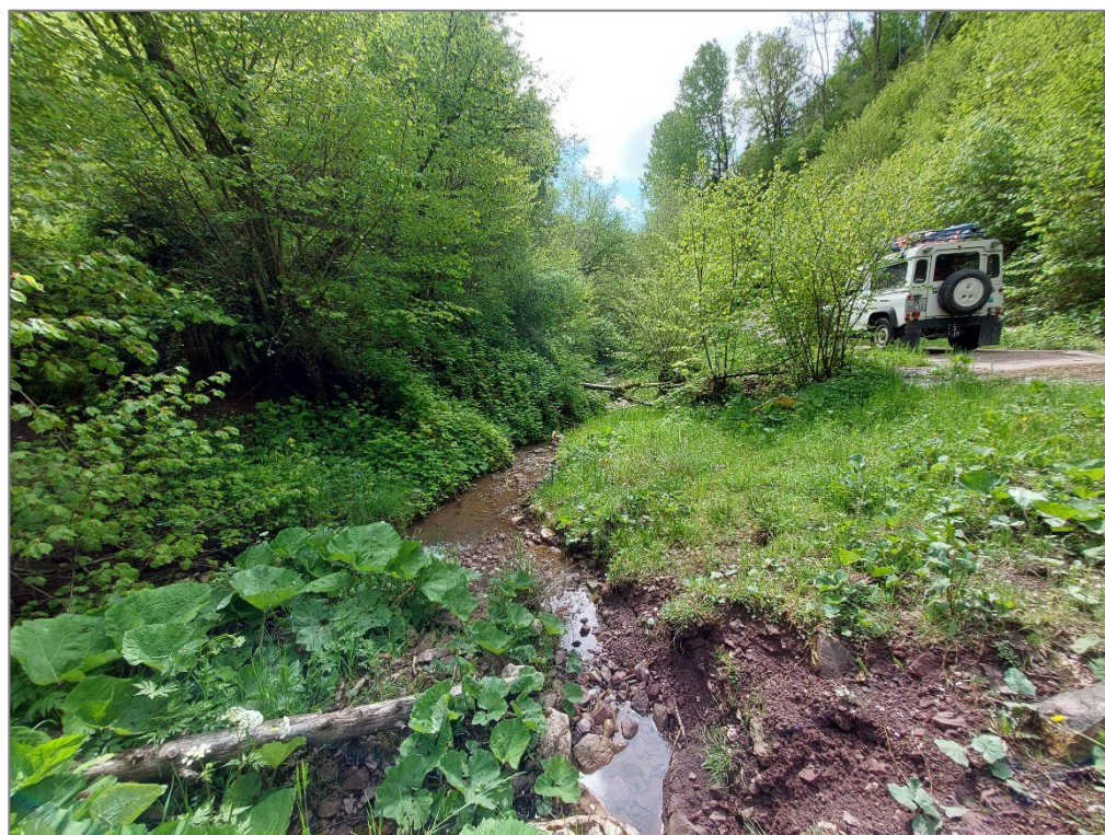
Figura 40 – Tratto 3A – 3B – Realizzazione vasca
