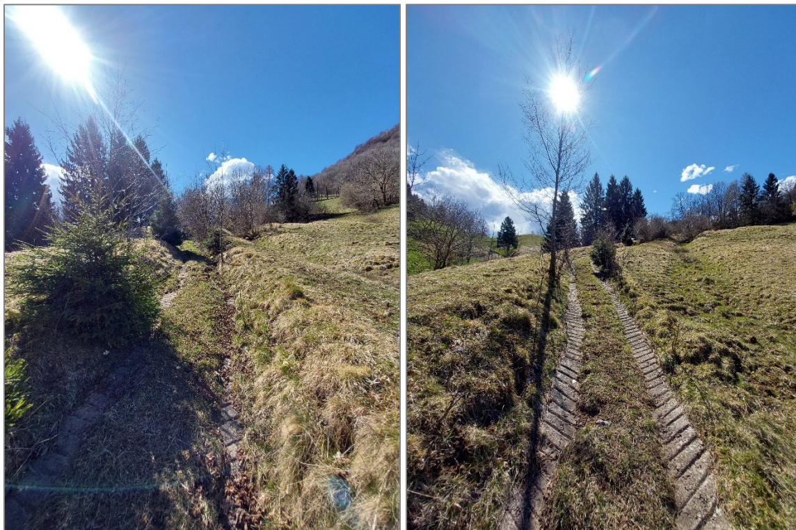
Figura 7 – Tratto 1D - 1E – Demolizione pavimentazione esistente e realizzazione nuova pavimentazione in cls, con riprofilatura scarpate
