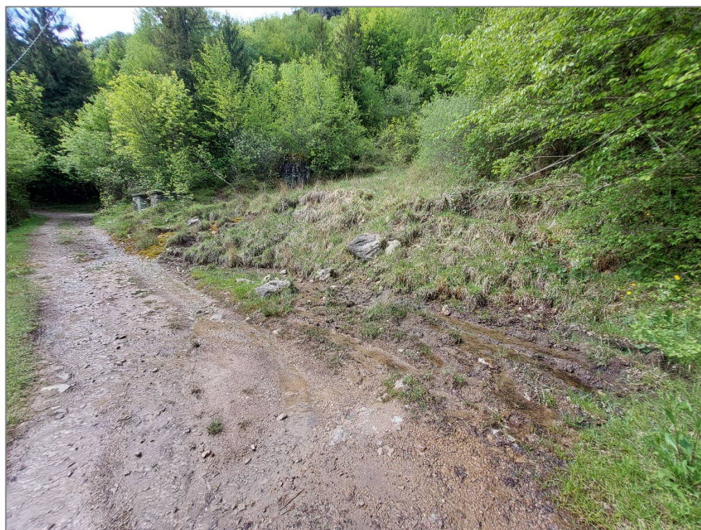
Figura 44 – Tratto 4B – Realizzazione nuova fontana tipo 4, con scogliera e selciato sul fronte
