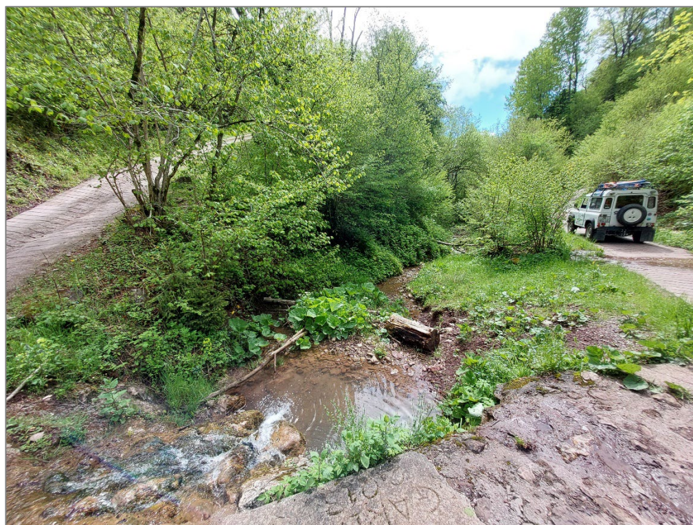
Figura 36 – Tratto 3A – 3B – Realizzazione vasca
