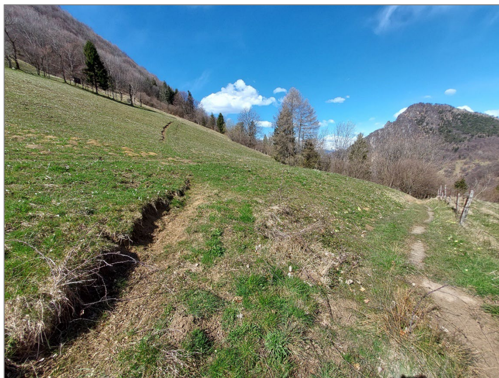
Figura 4 – Tratto 1D – 1E – Realizzazione piazzola di scambio
