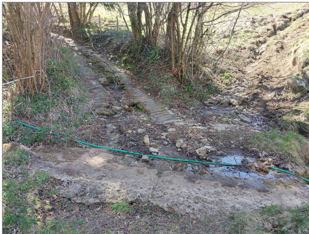
Figura 11 – Tratto 1F – 1G – Rifacimento attraversamento guado
