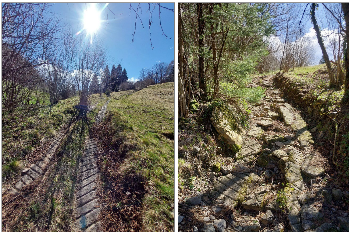
Figura 9 – Tratto 1E – 1F – Demolizione pavimentazione esistente e realizzazione nuova pavimentazione in cls
