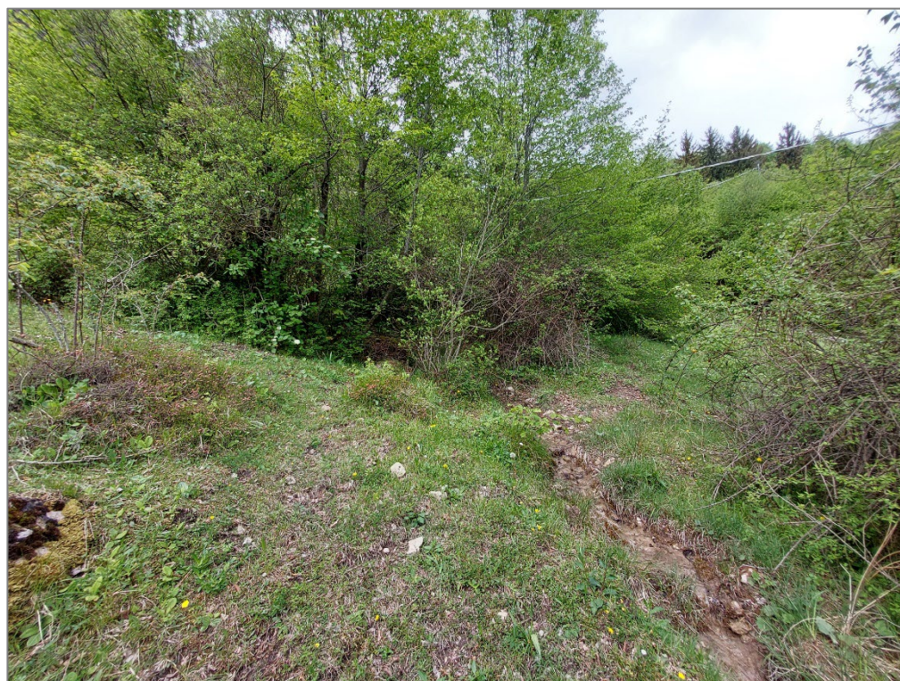
Figura 48 – Tratto 4E – 4F – Pulizia bosco e posa tubazione
