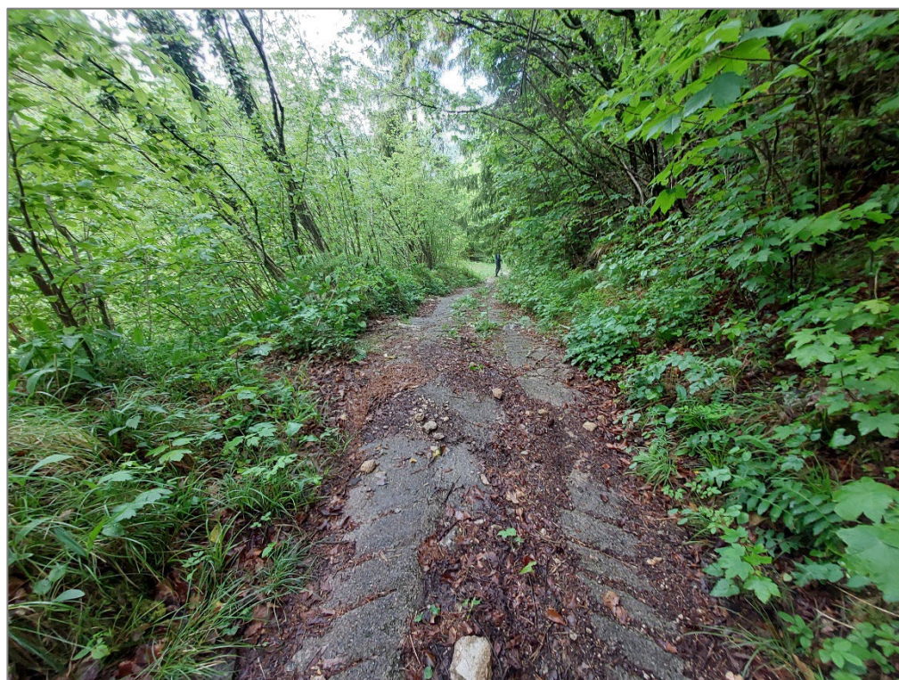
Figura 16 – Tratto 1G – 1L – Demolizione pavimentazione esistente e realizzazione nuova pavimentazione in cls
