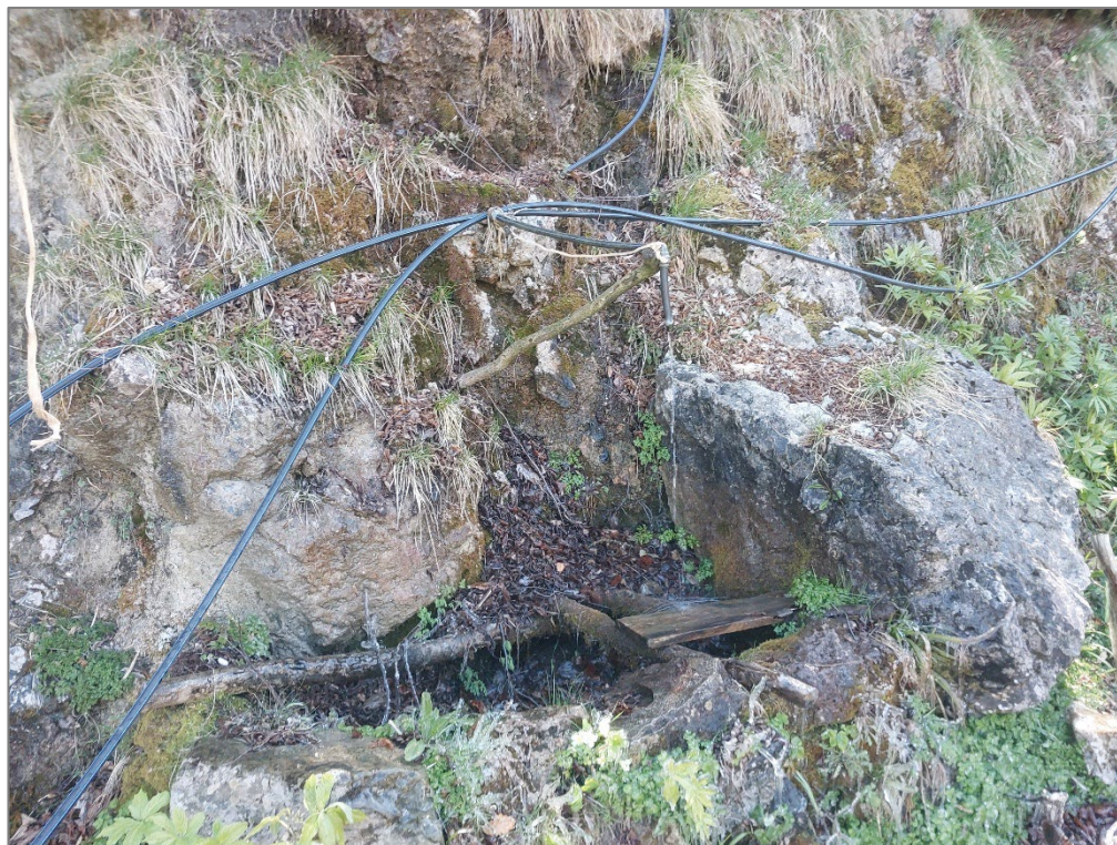
Figura 23 – Tratto 1L – 1H – Sistemazione fontana tipo 2
