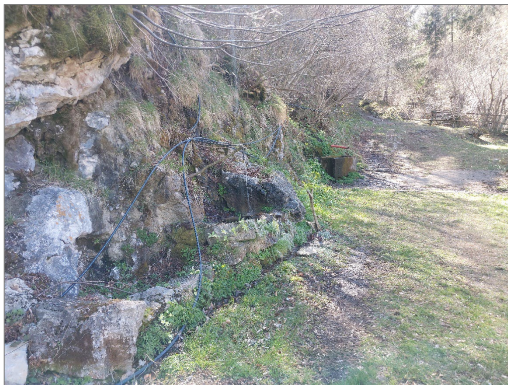
Figura 20 – Tratto 1L – 1H – Sistemazione fontane
