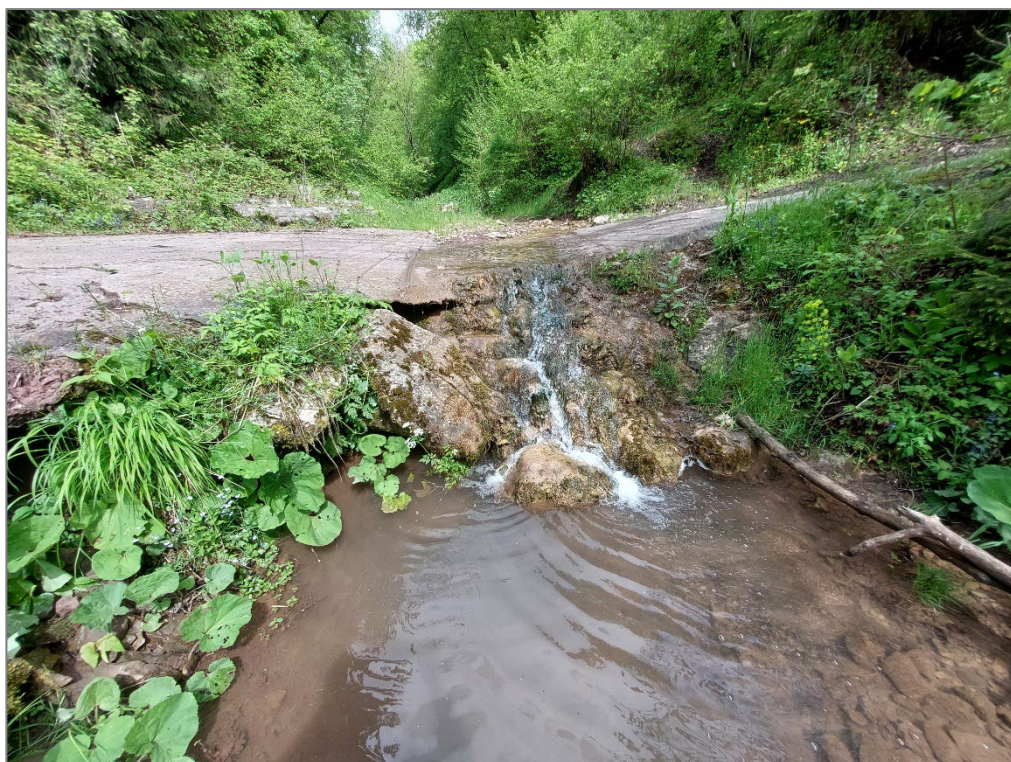
Figura 38 – Tratto 3A – 3B – Realizzazione vasca
