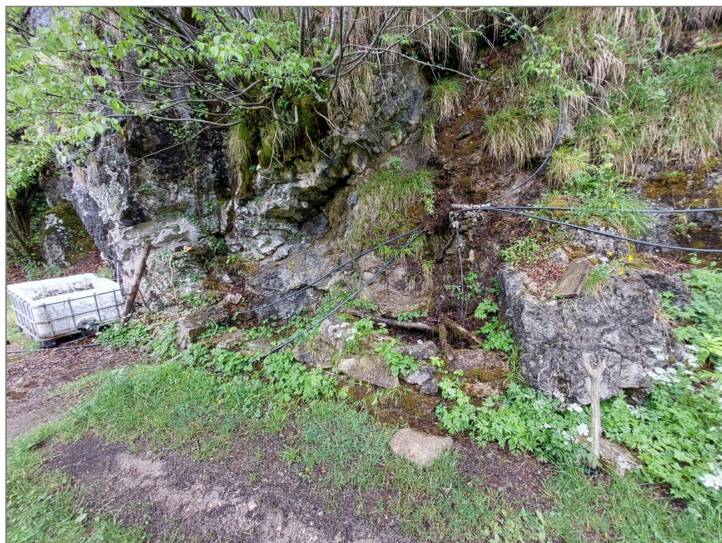
Figura 22 – Tratto 1L – 1H – Sistemazione fontana tipo 2
