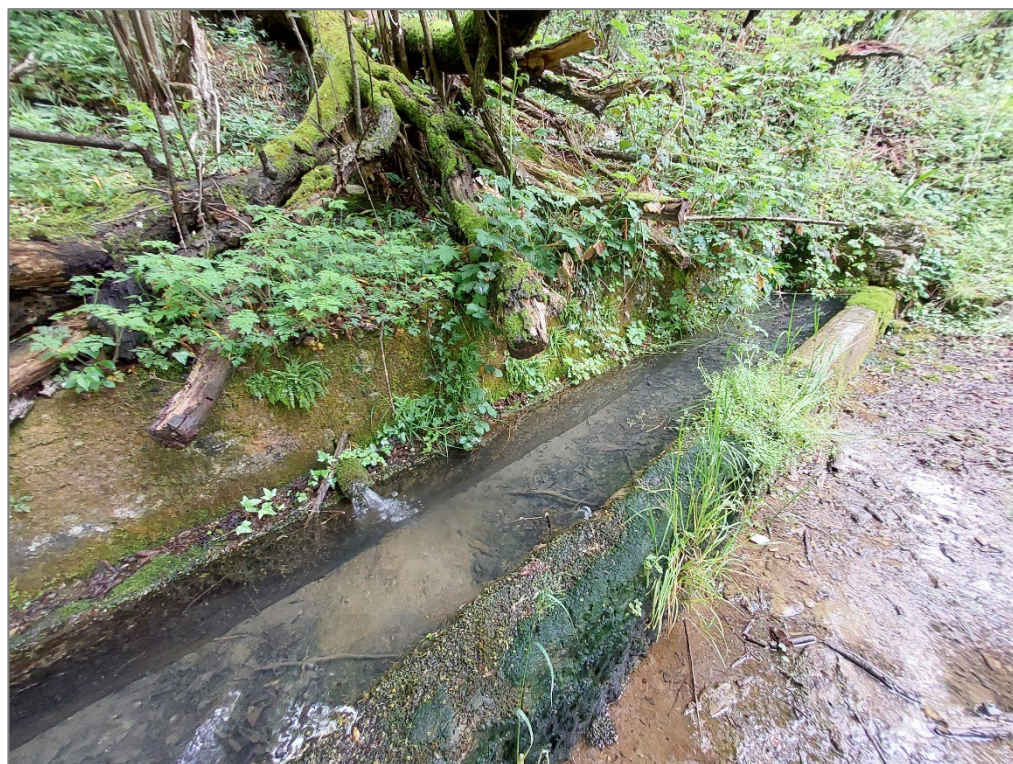
Figura 34 – Tratto 2E – Sistemazione fontana tipo 3
