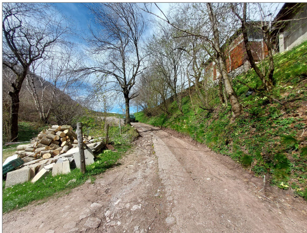
Figura 27 – Tratto 2A – 2B – Realizzazione raccordo con pavimentazione esistente
