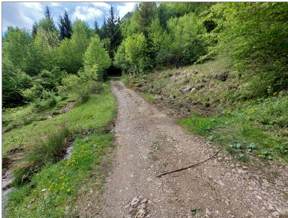
Figura 41 – Tratto 4C – 4D – Realizzazione pavimentazione in cls
