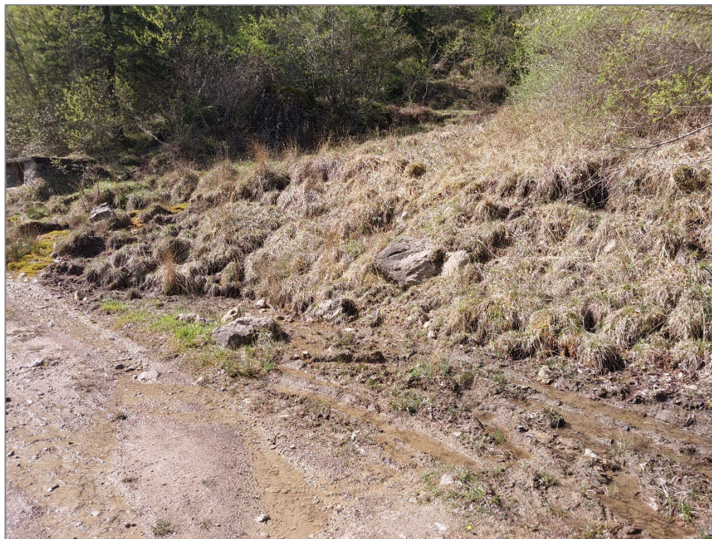
Figura 43 – Tratto 4B – Realizzazione nuova fontana tipo 4, con scogliera e selciato sul fronte
