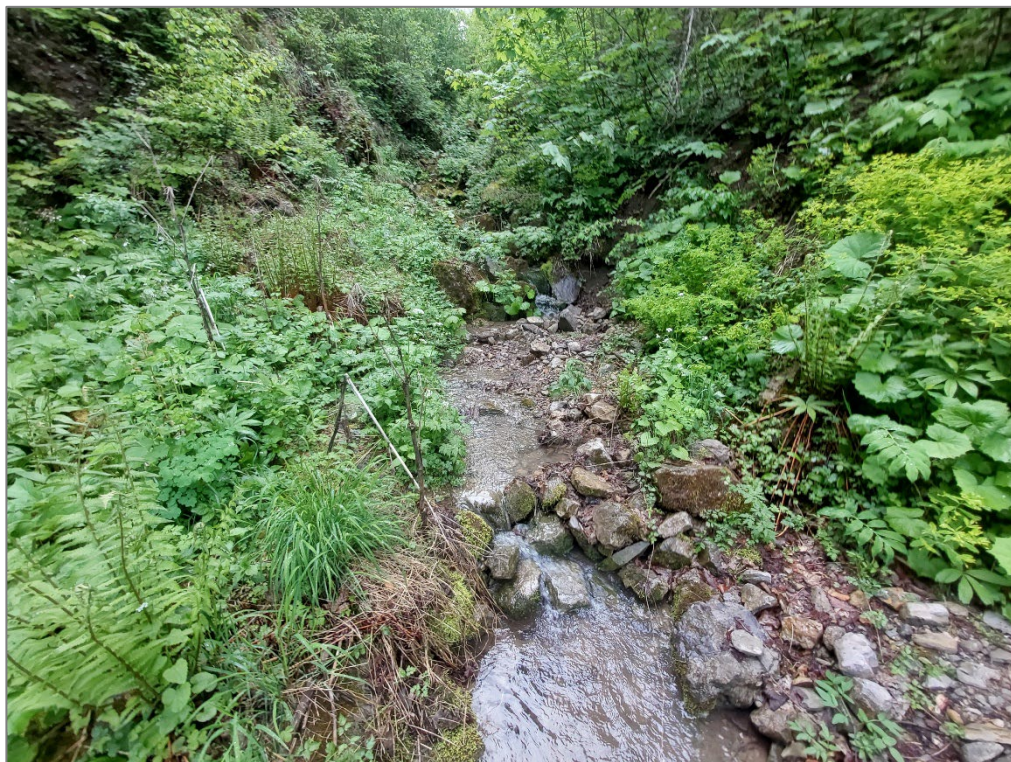
Figura 26 – Tratto1H – 1I – Pulizia bosco, realizzazione vasca
