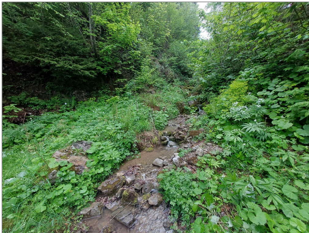
Figura 25 – Tratto 1H – 1I – Pulizia bosco, realizzazione vasca
