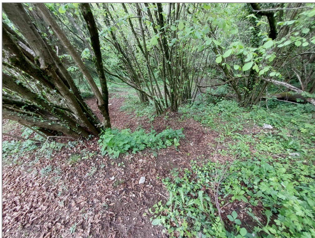
Figura 29 – Tratto 2E – Pulizia bosco e creazione sentiero di accesso
