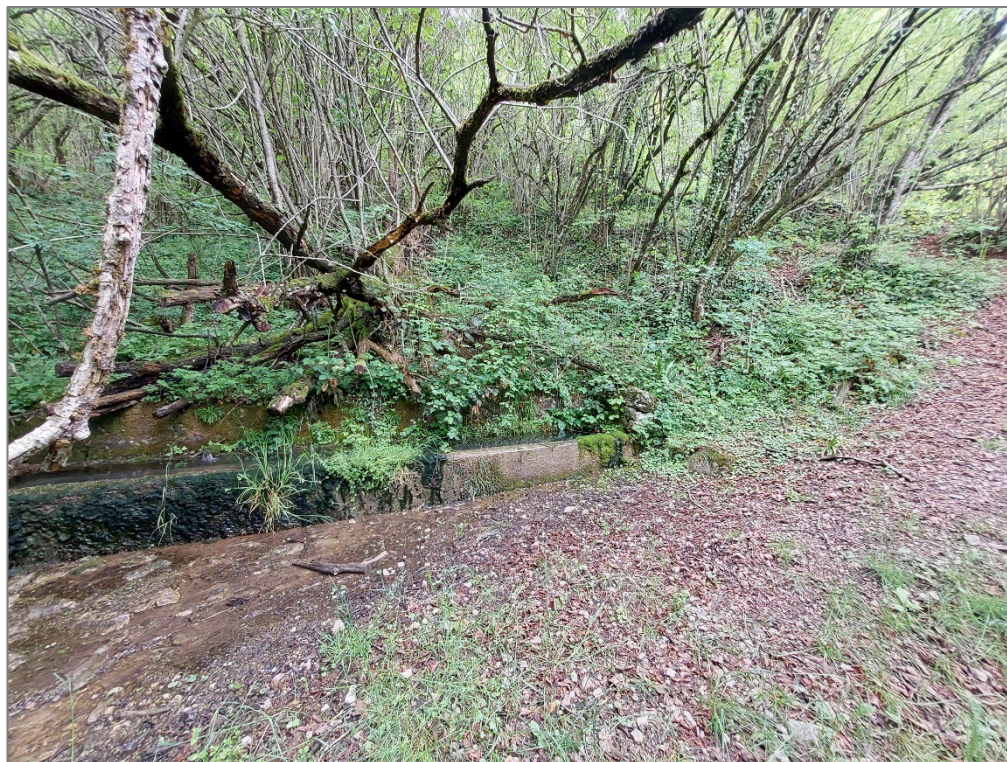
Figura 31 – Tratto 2E – Realizzazione selciato fronte fontana e sistemazione fontana tipo 3
