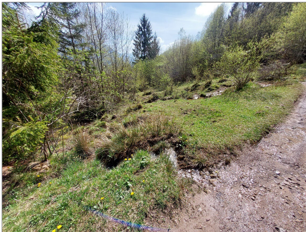
Figura 47 – Tratto 4E – 4F – Pulizia bosco e posa tubazione
