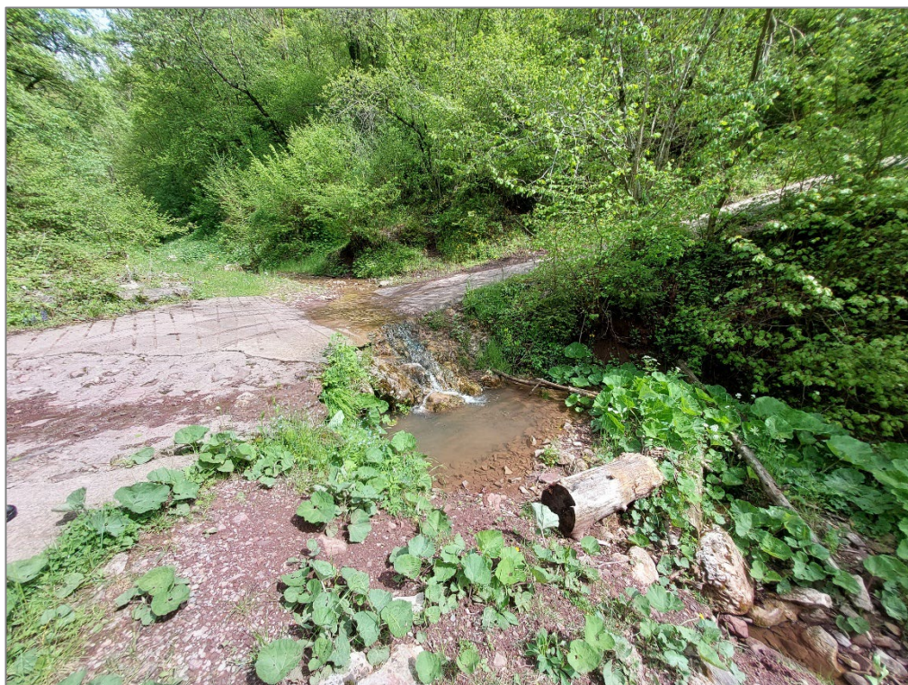
Figura 37 – Tratto 3A – 3B – Realizzazione vasca
