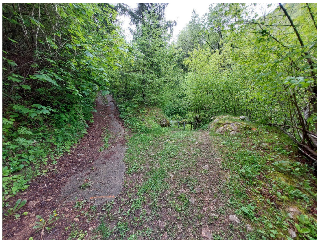
Figura 18 – Tratto 1L – 1H – Realizzazione nuova pavimentazione in cls incrocio strade
