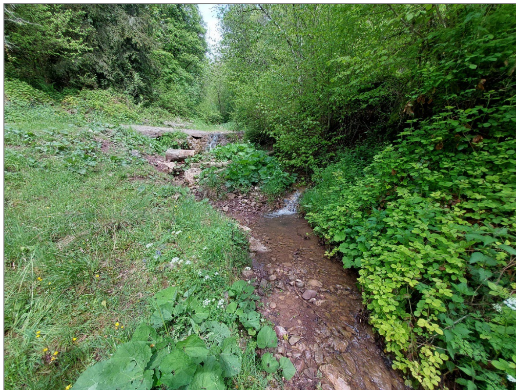
Figura 39 – Tratto 3A – 3B – Realizzazione vasca
