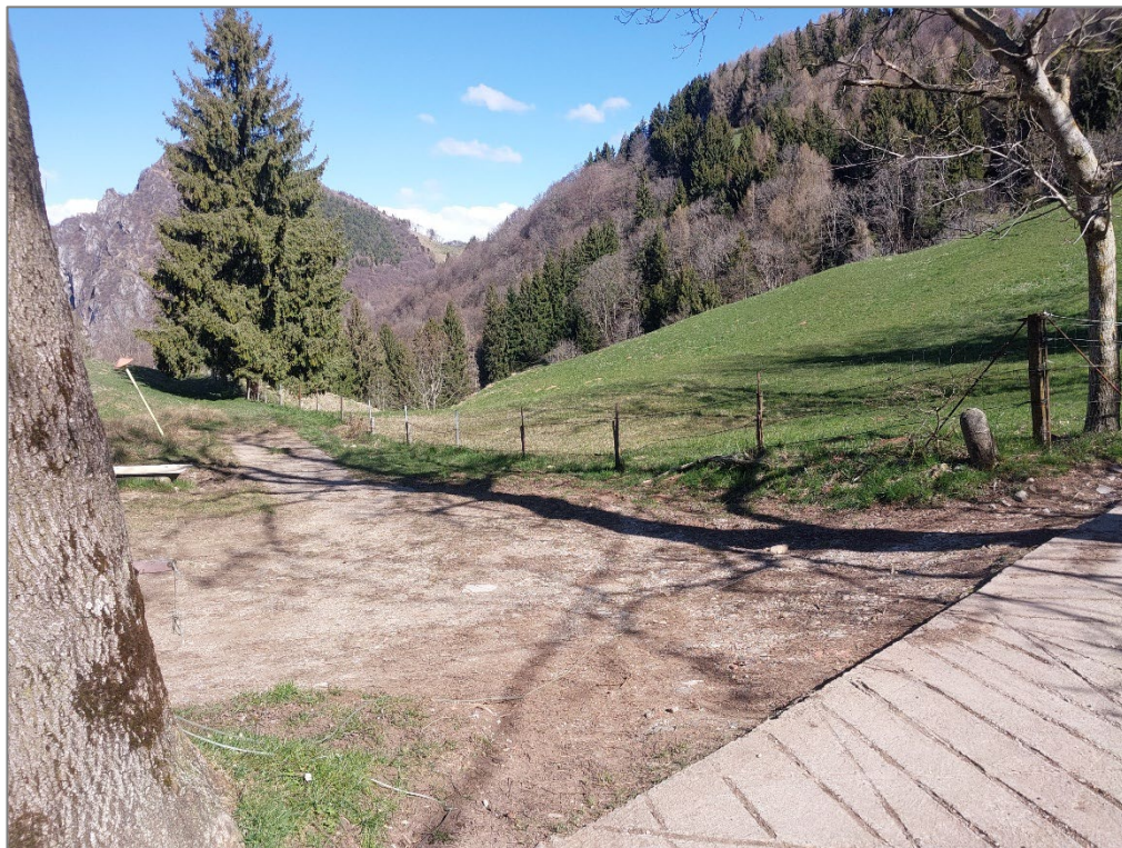
Figura 1 – Tratto 1A - 1B – Realizzazione raccordo con pavimentazione esistente
