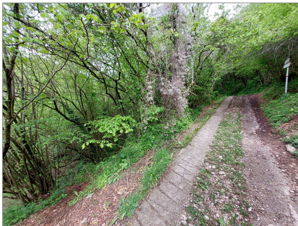
Figura 28 – Tratto 2E – Pulizia bosco e creazione sentiero di accesso
